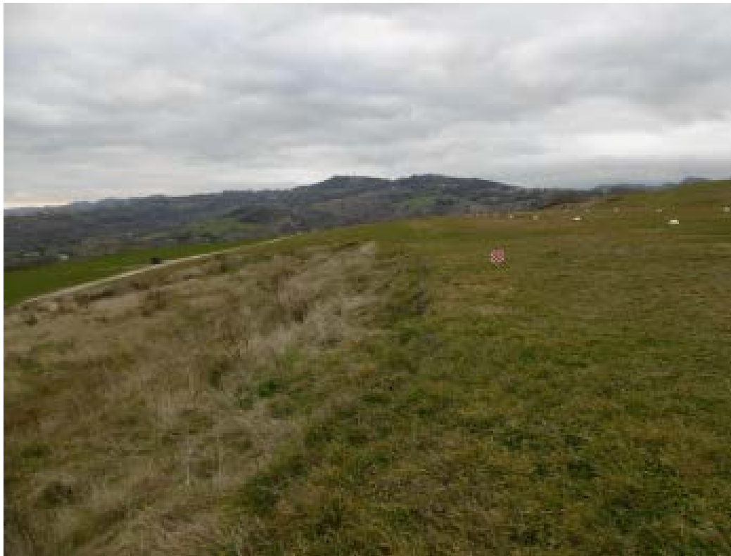
Fig. 6 – Particolare della zona di distacco del movimento franoso che interessa il limite orientale della pista nella sua parte centrale, vista da nord.
